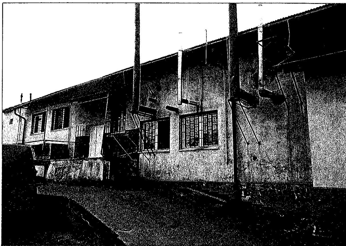
Zadní část budovy s nájezdovou rampou
