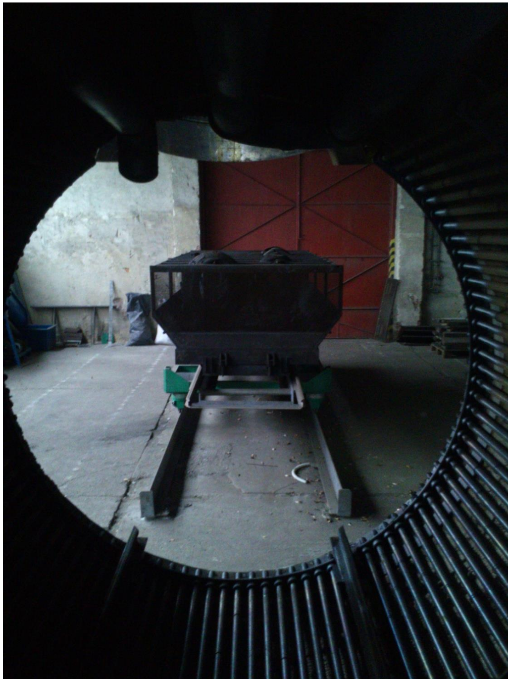
Obrázek č. 1: Pohled z komory termické jednotky Hoks TS 500 na převážecí vozík
